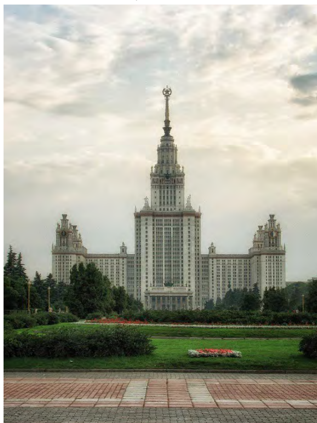
Edificio principale Università di Mosca 1949/1953 (© Steven Pavlov)
